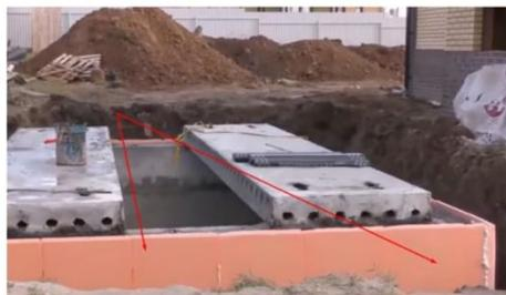
10 Теперь получившуюся конструкцию можно засыпать. Необходимо основательно протрамбовать грунт при засыпке, чтобы избежать его подвижек. Они могут оторвать теплоизоляционный слой.
