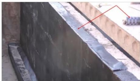
9 Утепление погреба производится также с внешней стороны. Для этого используют долговечный **пенополистирол** (пеноплекс), который обладает очень хорошими теплоизоляционными качествами. Крепится он на специальную клеящую пену. Ею же забиваются и все щели по углам.
