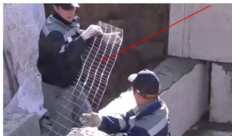
**5** Все оставшиеся зазоры тщательно забиваются цементным раствором и затираются, во избежание повреждения гидроизоляционного слоя об острые края бетонных блоков.
