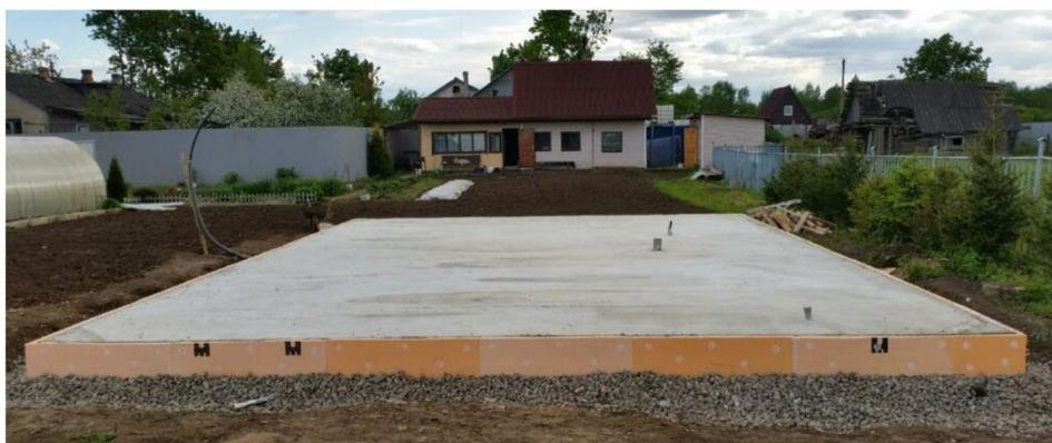
Для усиления основания желательно брать арматуру диаметром 12 мм. Расчёт необходимого количества выполняется в погонных метрах. Из прутов монтируется решётка с ячейками, имеющими длину 15 см. Расчёт выполняют следующим образом:
