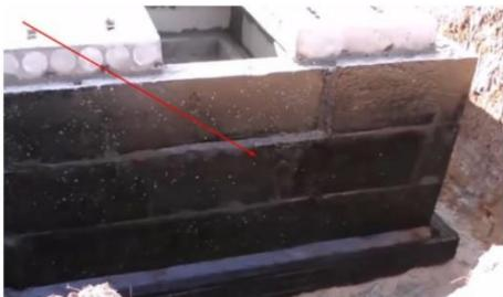
**8** В качестве гидроизоляции применяют бикрост, который разогревается горелкой на пропане и проклеивается на стену. Здесь следует следить, чтобы не оставалось воздушных пузырей. Впоследствии они повреждаются грунтом, и гидроизоляция становится бесполезной.
