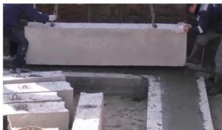
**4** Между рядами бетонных блоков (оптимальным для гаража будет выбор блока ФБС 300x580x2380) обязательно прокладывается армирующая сетка – она придаст жёсткости сцепке блоков между собой.
