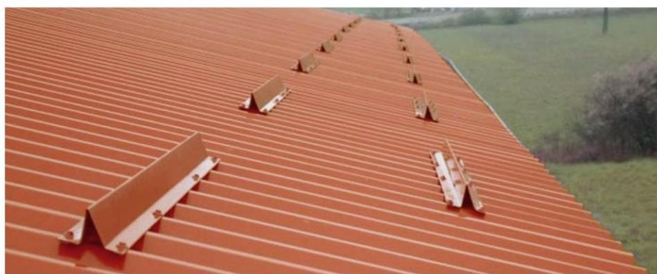
Пластинчатые или угловые устройства для задержания снега не слишком прочны.
