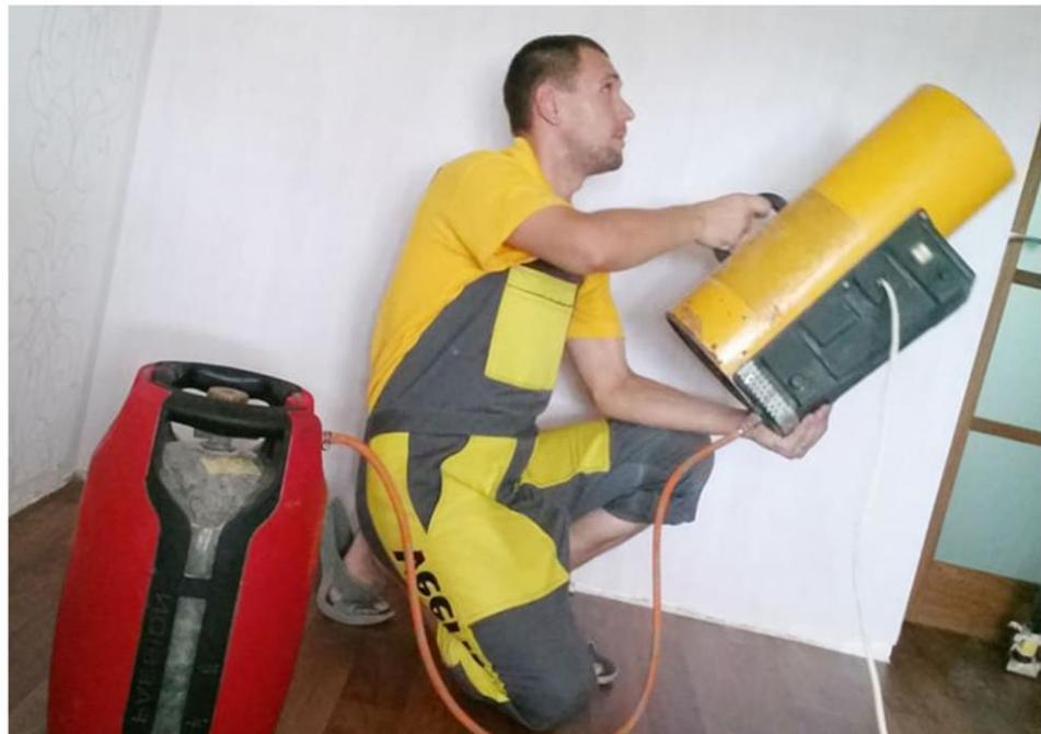
С помощью газовой теплой пушки можно разогреть плёнку до оптимальной температуры.
