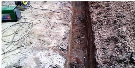
**8** После монтажа горизонтально-го заземлителя нужно соединить его проводником с щитком. Для этого на конце привариваются крупные болты, на которые и будет закреплен проводник. Места сварки можно обработать от коррозии специальным составом, но сам контуру ни в коем случае не окрашивается!
