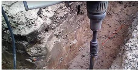
**6** В режиме долбления постепенно забивайте штыри на глубину, оставляя на поверхности траншеи примерно 20-25 сантиметров стержня.
