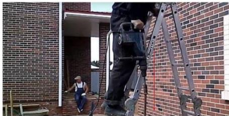
**7** Когда все вертикальные шины будут вбиты, приварите к ним металлическую полосу. Не рекомендуется заменять сварку болтовыми соединениями. В процессе окисления контакт горизонтального и вертикального заземлителя будет нарушен.
