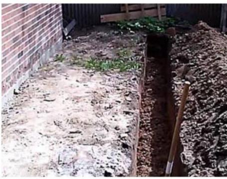
**4** Расстояние между вертикальными заземлителями – 1.5÷2 метра. Чтобы облегчить процесс забивания стержни заостряют. Если используются уголки, они тоже обрезаются на концах так, чтобы легко входили в землю.
