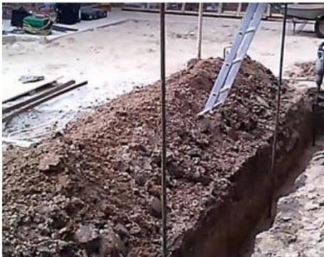
**5** Если вы используете стальные стержни, можно механизировать труд своими руками. Контур заземления в частном доме можно забивать с помощью специальной насадки на перфоратор.
