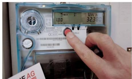
Счётчики электроэнергии с передачей данных применяются для автоматизации таких процессов, как сбор и отсылка информации поставщику, а также анализ уровня энергопотребления. Задействование информационно-измерительных систем в работе энергетических компаний-поставщиков позволяет не только получить данные о потребляемой электроэнергии, но и приобрести ряд возможностей, ранее недоступных при использовании традиционных приборов учёта.
