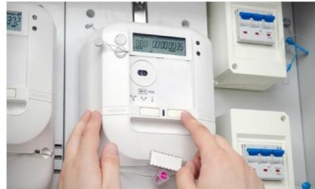
Часто производители оснащают приборы учёта функцией регулировки уровня мощности электросети. В случае превышения потребляемой мощности, счётчик автоматически прерывает доступ к электропитанию. Это стало возможным благодаря
